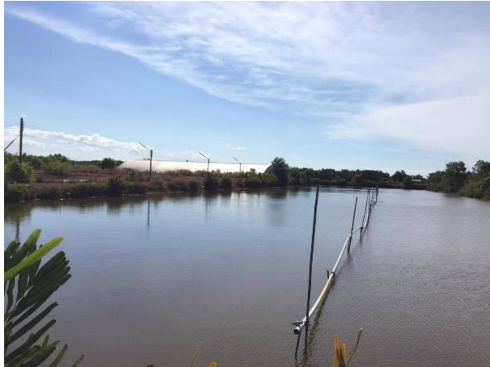
ภาพที่ 4 บ่อน้ำทิ้งและบ่อบำบัด
