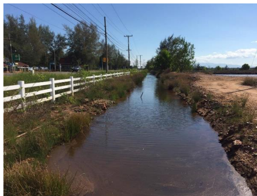
ภาพที่ 2 การสำรองน้ำโดยใช้คูน้ำล้อมรอบศูนย์วิจัย
